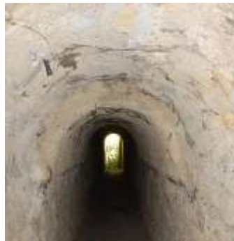
4 bis) Aqueduc SNCF (détail)
