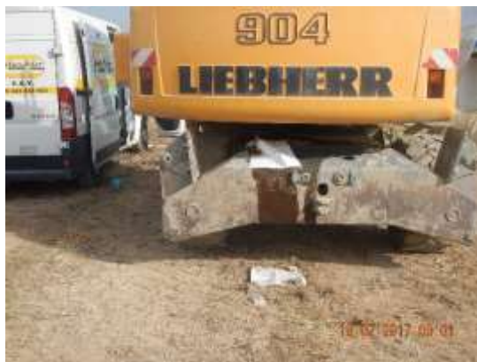
Kit de pollution au niveau d'engins de chantier
