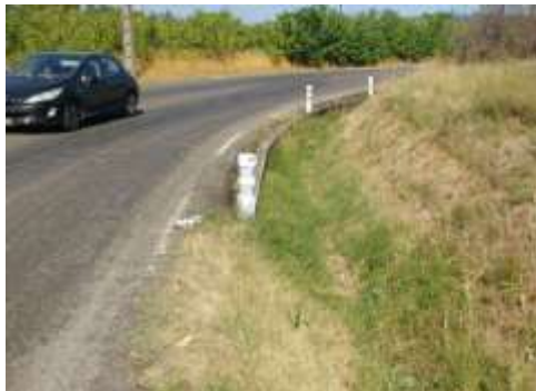
4) Fossé RD609 puis aqueduc sous la voie ferrée (diamètre 800 mm)
